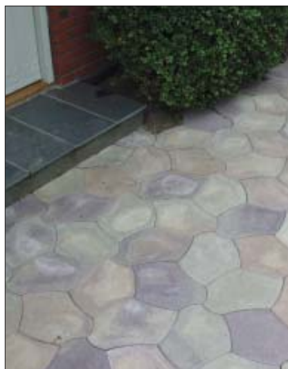
Til venstre ses almindelige kalkudfældninger på farvede sten. Billedet til højre viser samme belægning 2 år senere. Det ses, at kalkudfældningerne er væk, hvilket skyldes almindeligt slid samt vind og vejr generelt.
