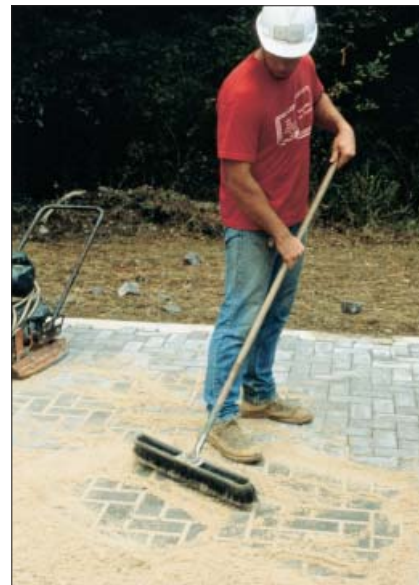
Fugegrus fejes i fugerne inden første vibrering.
